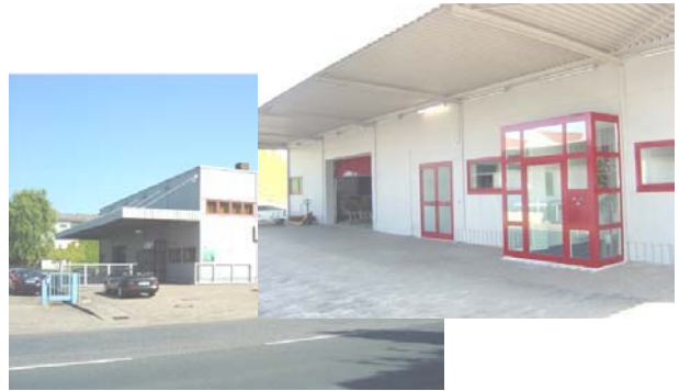
Firmengebäude in Isernhagen/Altwarmbüchen
